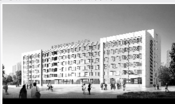
建设中的项城市第一人民医院病房楼
